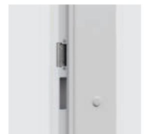
regulowany zaczep zamka w ościeżnicy metalowej (opcja do wyboru)
